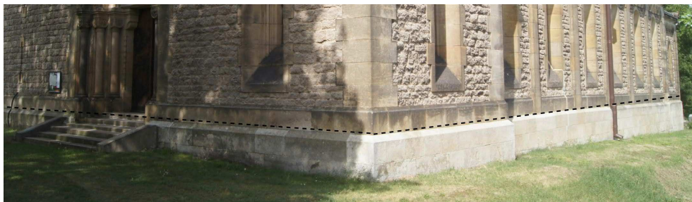
Obrázek 10: Pohled JV: rozdíl v poklesu základů vlivem svahových pohybů
